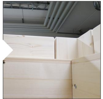
5. Montieren Sie die Deckenelemente. Schrauben Sie nur das erste und das letzte Element an.
