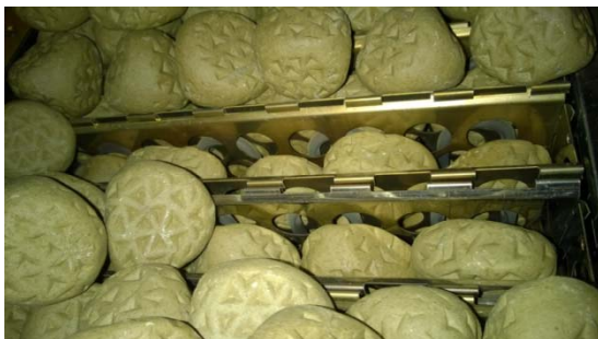
Kivikori asennettuna, Tetra kiviä ladotaan peitoksi
